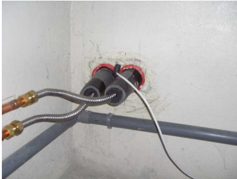
L'arrivée des lignes solaires dans le sous-sol (pendant les travaux)
