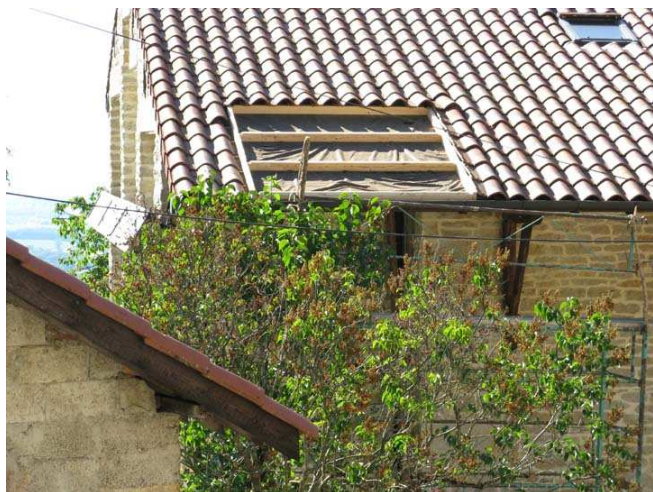
Le cadre est prêt, sur une avancée de toit. Dessous : le vide, pas la maison.
