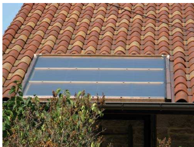
Zinguerie terminée et soleil : il reste les raccordements à faire
