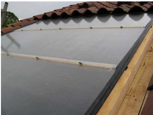
Les vitres ont été mises avec les premières gouttes de pluie,
