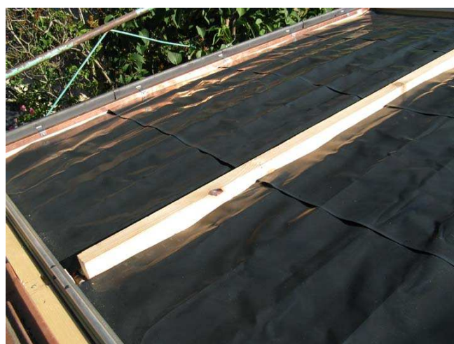
Dans l'encoche : le raccord brasé entre les deux absorbeurs Les essais sous pression sont bons : on va pouvoir mettre les vitres.
