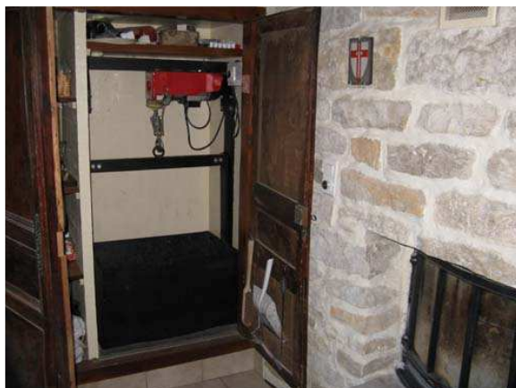
L'ascenseur en haut à côté du foyer bois... tableau électrique, le variateur du ventilateur, le boîtier de commande par téléphone.
