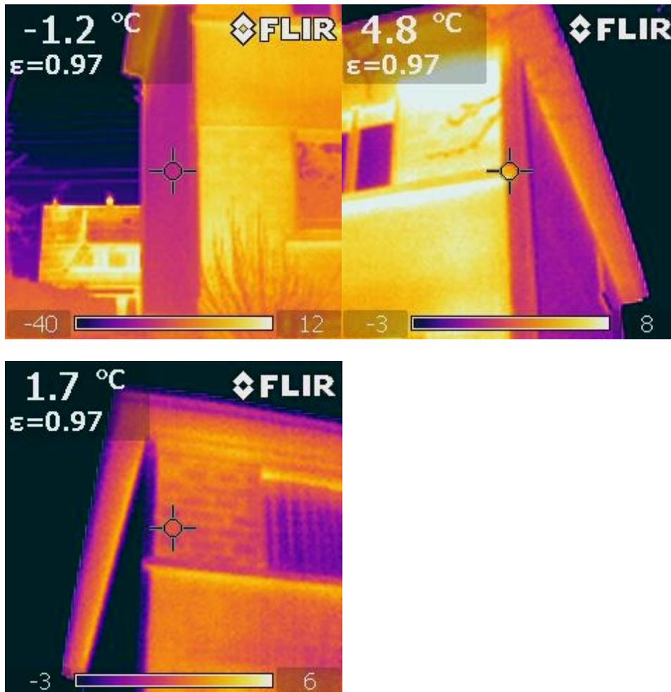
Et Les ponts thermiques restant apparaissent clairement sur les photos.
