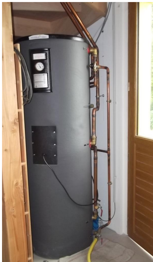
Chauffe-eau 300 l simple échangeur
