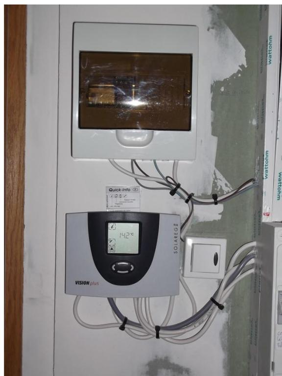
Régulation Vision et contacteur de la vanne 3 voies
