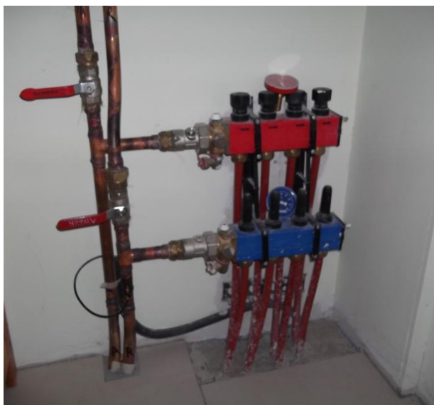
Nourrices du circuit PSD et départ vers l'étage
