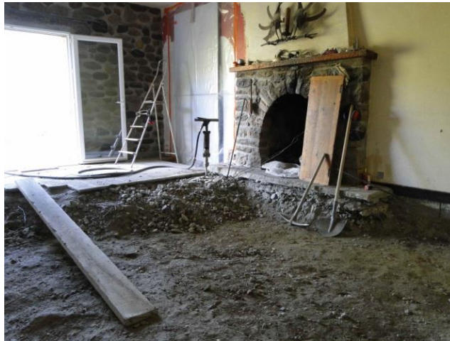
Figure 5: décaissement de l'ancien plancher béton du séjour
