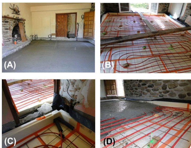
Figure 7: plancher chauffant du séjour et du bureau. (A) Dalle de propreté, (B) les deux boucles de tube dans le séjour, (C) le passage séjour - bureau, (D) coulage de la dalle chauffante.
