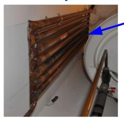
Le vase d'expansion est à l'air libre. Il a été réalisé à l'aide d'une barre de cuivre en 26-28. D'un volume de 3,7 litres, il autorise la dilatation des 30 litres du circuit primaire avec une marge de sécurité.
