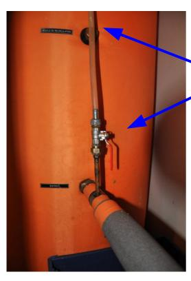
Au point le plus haut, juste à l'entrée de l'échangeur du cumulus solaire de 400 litres, nous avons installé une durite transparente pour voir le niveau.
