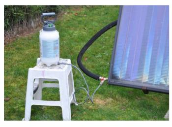
Le circuit primaire est raccordé à un pulvérisateur de jardin dans lequel est introduit le liquide antigel solaire et sanitaire neuf.
