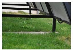
Le châssis est fixé à deux blocs bétons coulés sur place à l'aide de chevilles chimiques
