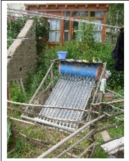
Capteurs à tubes pour l'ECS devant une serre solaire passive
